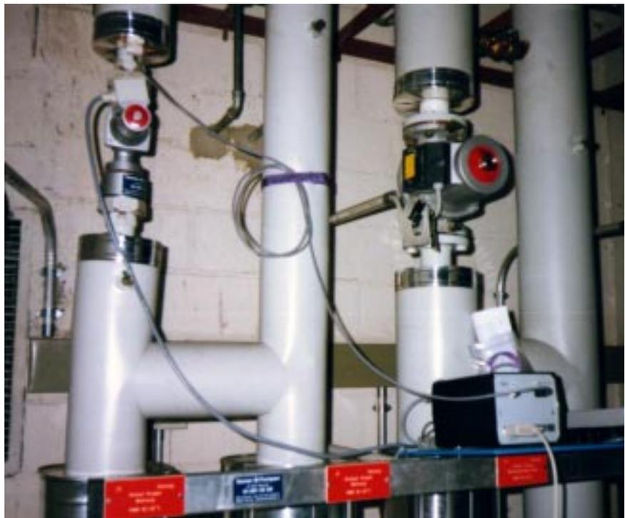
Bild 2 Biral-Pumpe MC 10 im Testbetrieb, mit Messmodul (unten rechts), AWEL Zürich, Gruppe Wohnung (links)
